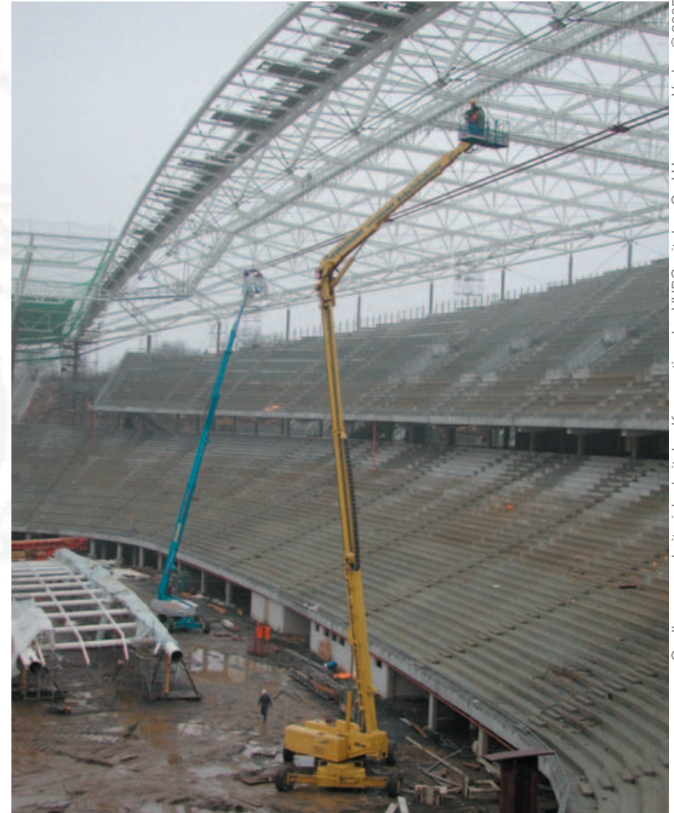
Bild 5-1: Hubarbeitsbühne im Baustelleneinsatz
